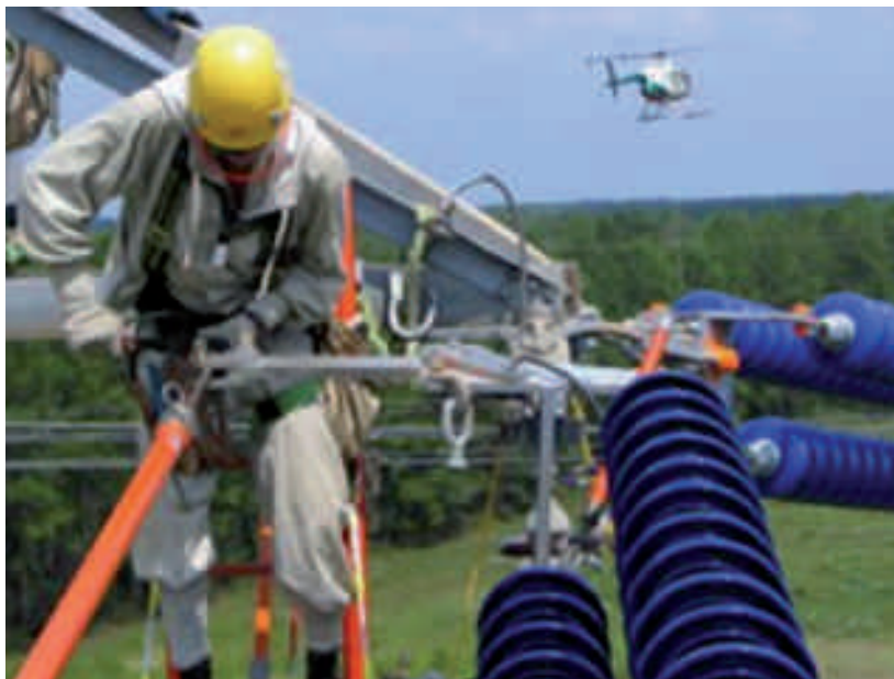
Fig. 9 – Técnico a trabalhar em linhas de alta tensão
