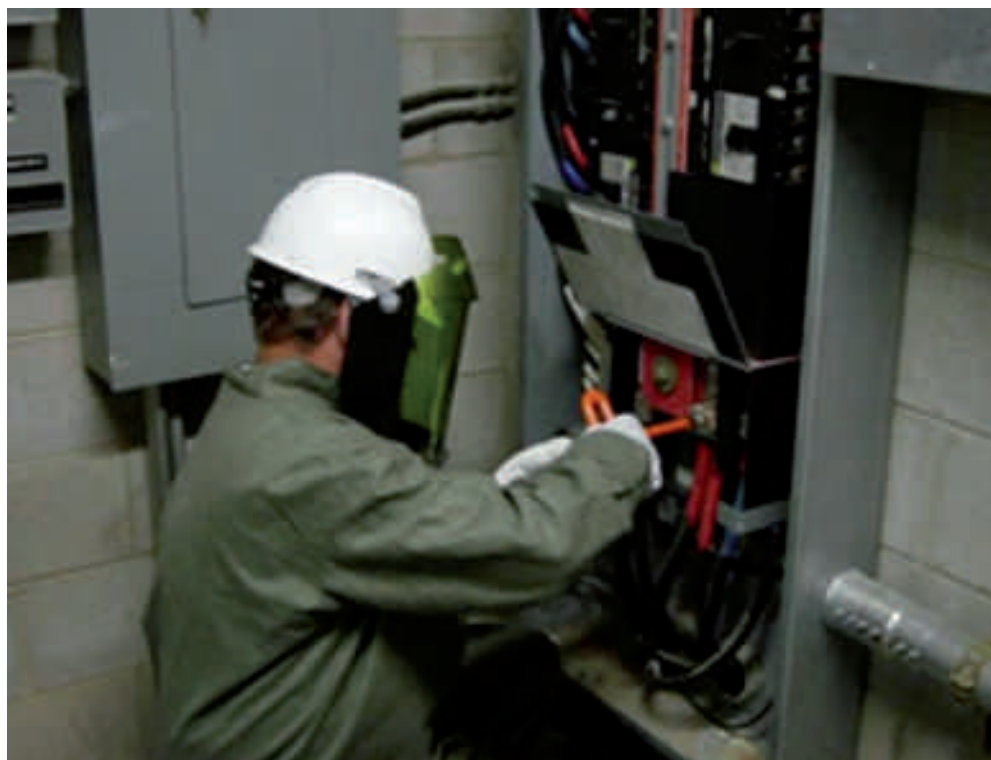
Fig. 6 – Trabalho em eletricidade (baixa tensão)
