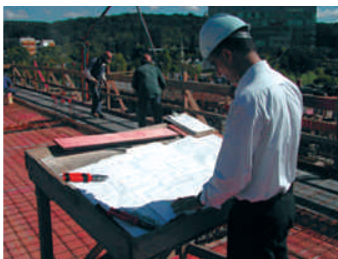
Fig. 5 – Engenheiro em acompanhamento de obra
